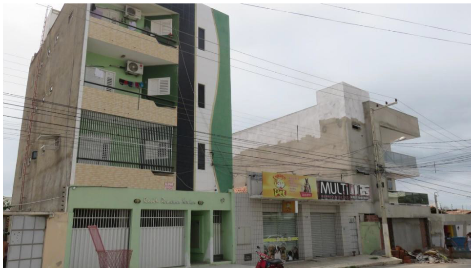
Figura 08 - Mudança de uso na Rua Monsenhor Gurgel, com uso edifício residencial (esquerda), comercial (centro) e quitinete vertical (direita).
